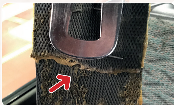
INTERIOR: Cinturón de seguridad modificado, grapado y pegado.
